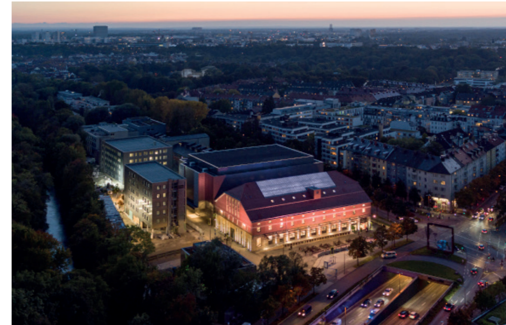
Konzertsaal im Windschatten der Trafohalle
